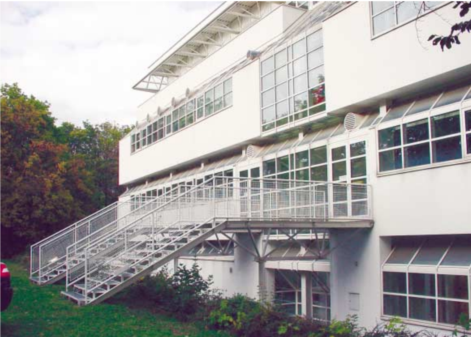
Die Westfassade nach der Sanierung. Foto: Gordana Brandner
